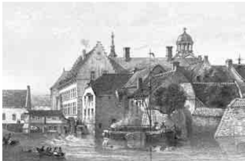
Figure 1 : Le pignon Nord et la façade Est de l'hôpital vus depuis la Dendre
