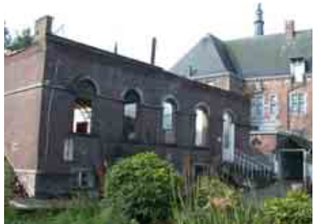
Figure 15 : Salle des Malades 19 ème (Rive droite)
