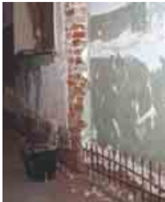
Figure 18 : changement d'épaisseur du mur
