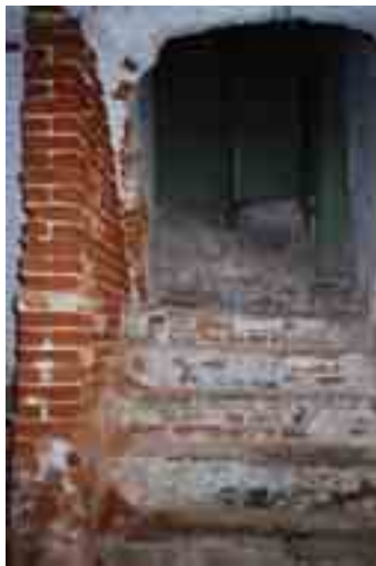
Figure 36 : Escalier de cave
