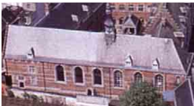
Figure 42 : Façade extérieure (Sud) : deux styles
