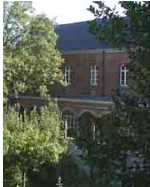
Figure 17 : Le bâtiment des Espagnols vu depuis l'entrée de la glacière
