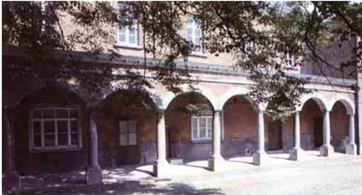
Figure 24 : Bâtiment des Espagnols (côté Dendre)
