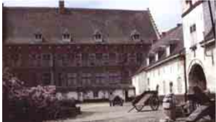
Figure 61 : La cour de la ferme (vue depuis l'Est)
