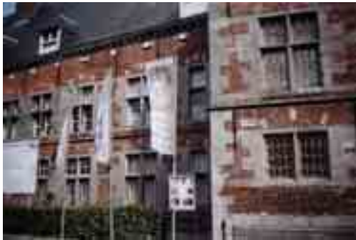
Figure 50 : Facade extérieure (Ouest)
