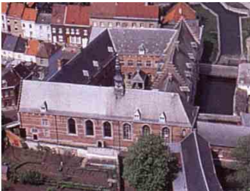
Figure 8 : Vue aérienne du quadrilatère (depuis le Sud)
