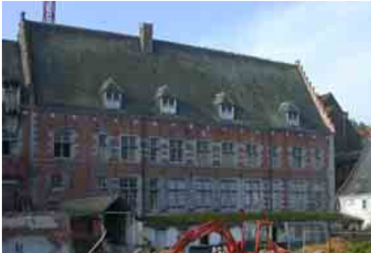
Figure 32 : L'aile Est initiale entre les deux pignons à redents et la jonction accolée sur sa gauche
