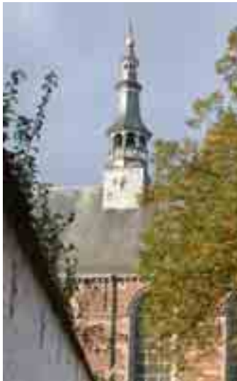
Figure 40 : Le clocher et la chapelle vus depuis la Cour des Malades
