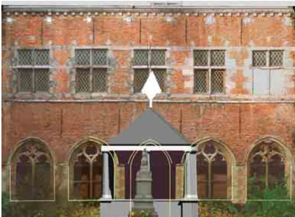
Figure 54 : Façade du cloître (Nord)
