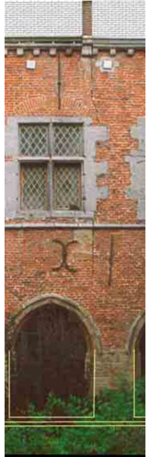
Figure 38 : Façade côté cloître (Est) au droit du pignon à redents
